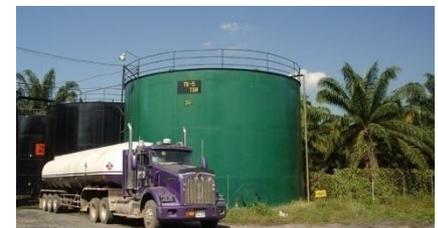
Cuando se construyen tanques de almacenamiento se acostumbra, por economía, aumentar el espesor de los primeros anillos. En las plantas extractoras se usan láminas de acero al carbono de  $\frac{1}{4}$ " de espesor en los primeros anillos y de  $\frac{3}{16}$ " en los restantes.
